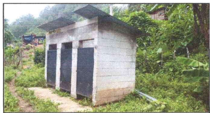
Foto 6: Entechado y repello de baños.
